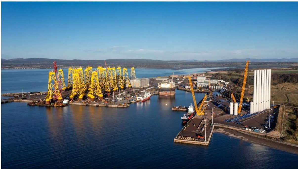
Hình 4-1: Một ví dụ về cảng phục vụ điện gió ngoài khơi. [4]
