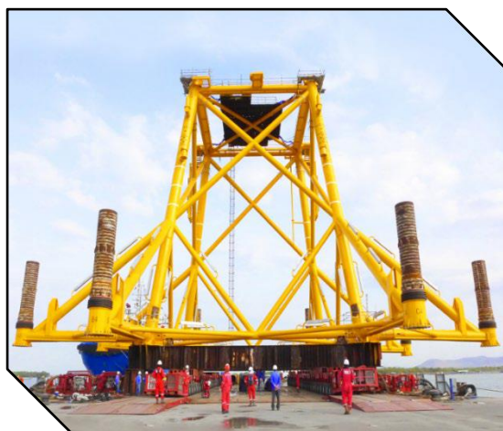
Kết cấu thép lớn do Alpha ECC sản xuất
