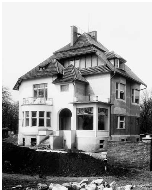
Výstavba vily v Bubenci v roce 1909
